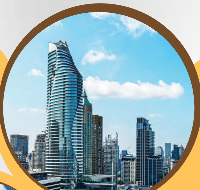
โครงการโรงแรมวอลดอร์ฟ แอสโตเรีย กรุงเทพฯ และเซอร์วิส อพาร์ทเมนต์ MRB
